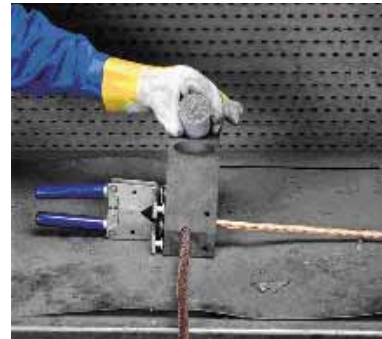
STEP 3: Pour weld metal into mold.
